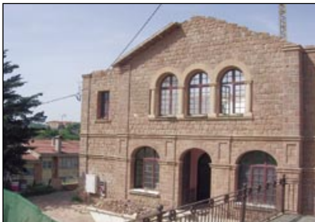
Obres de rehabilitació de les antigues escoles Escasany
