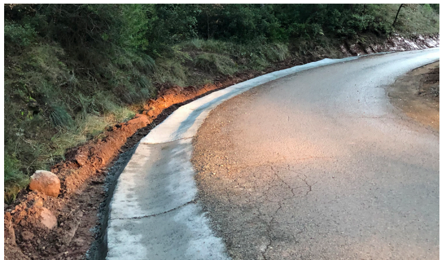
S'ha fet un accés nou des de la carretera C-55 i també s'han construït cunetes de formigó
