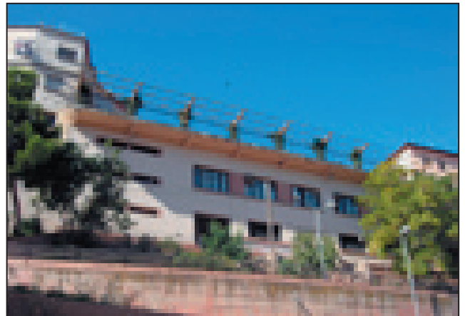
Imatge actual de l'edifici que ha d'acollir el Centre Cívic i Casal de Joves
