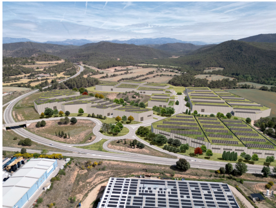
Obres del nou Polígon La Cort II
